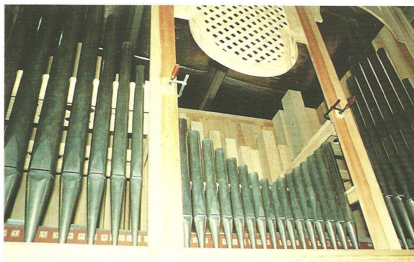
En cours de réalisation.
